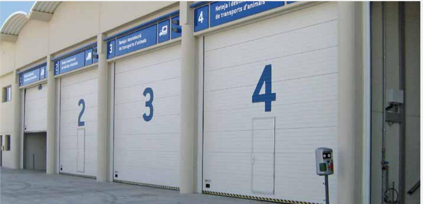
Puertas seccionales panel sándwich con puerta peatonal en túneles de lavado.
