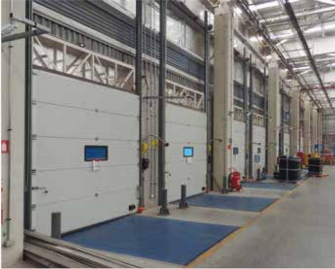
Puertas seccionales, rampas niveladoras Hydra y luces Verslight en muelle de carga.
