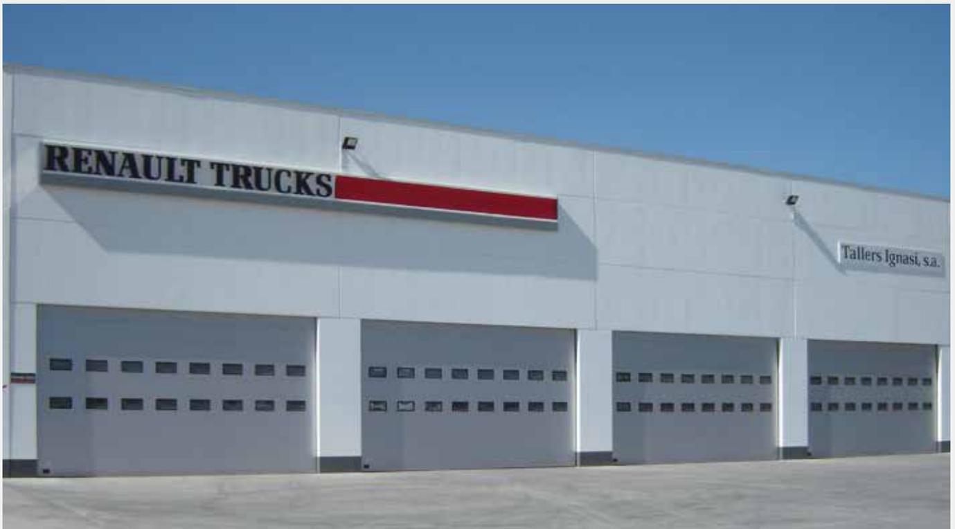
Puertas seccionales panel sándwich con mirillas en concesionario.
