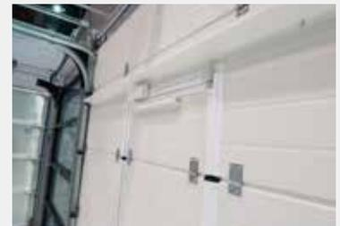
Detalle muelle retenedor y micro de seguridad.
