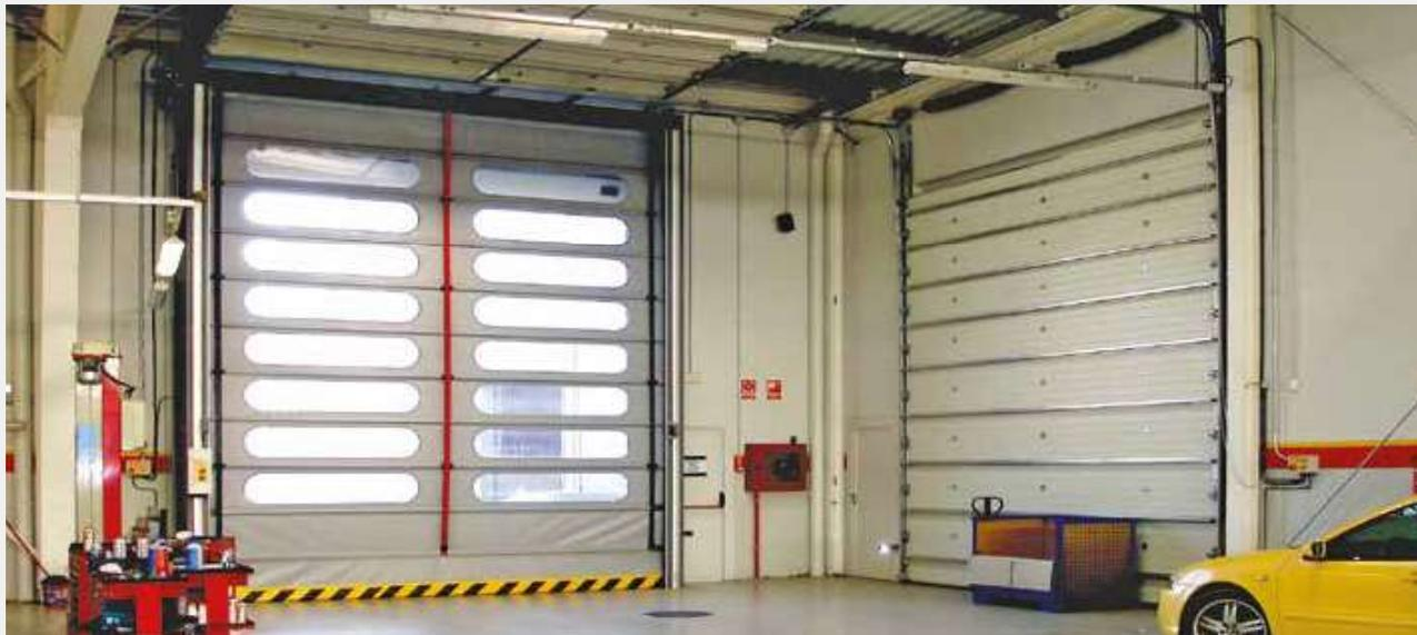
Ángel Mir® dispone de soluciones para la instalación de puertas rápidas en combinación de puertas ya instaladas. Aprovechando la puerta existente, mediante cerramientos, retranqueos y remates de ajuste entre ambas.
