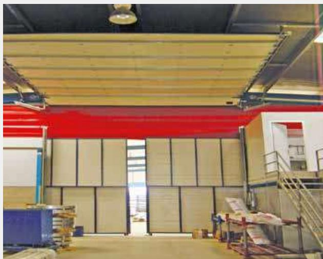
Puerta rápida combinada con puerta seccional y corredera.
