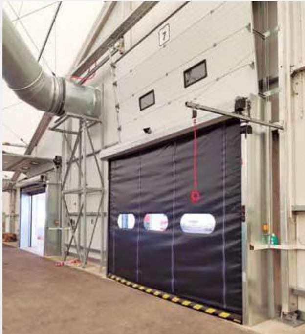
Mirzip® combinada con puerta seccional para edificio temporal.
