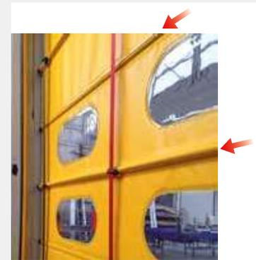
Sistema de varillas desmontables que permite el recambio del telón y las ventanas por secciones.
