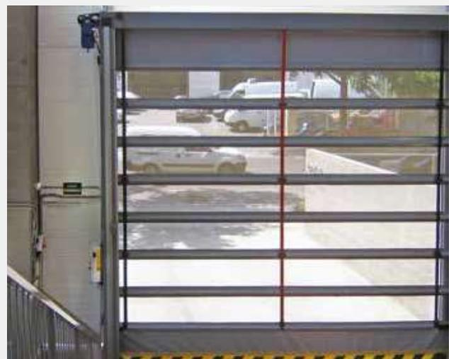
Puerta rápida perforada para ventilación.
