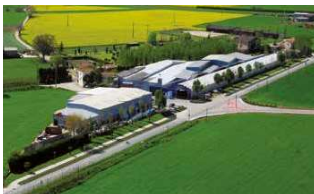
Instalaciones Angel Mir ® de 40.000 m 2
